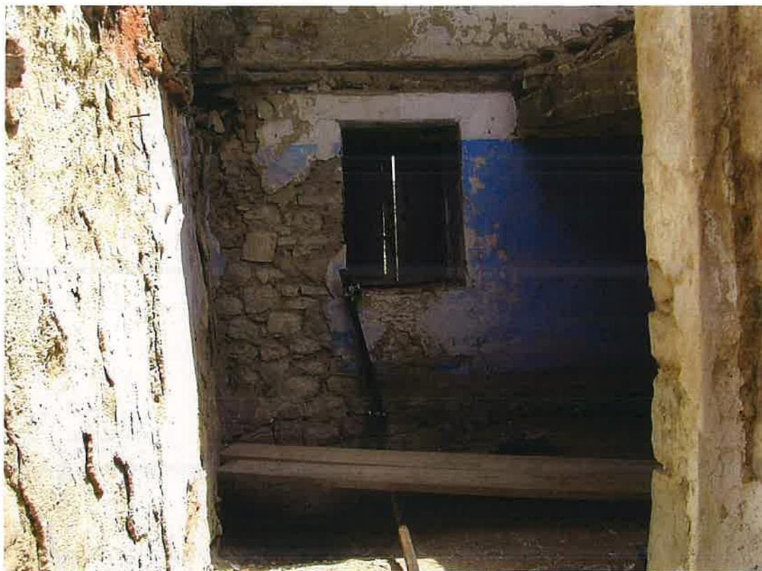
si intravede il solaio perso della stanza 2 e il solaio crollato della torretta
